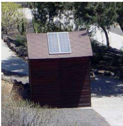
Electrificación Aislada con FV
