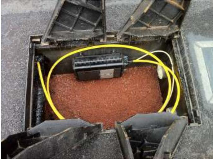
La red de IT<sup>3</sup> discurre por canalización enterrada tanto en las infraestructuras viarias como ferroviarias de Tenerife. Se trata de una red en anillo con una longitud cercana a los 200 kilómetros, con una capacidad máxima de 504 fibras ópticas y con todos sus tramos redundantes.
