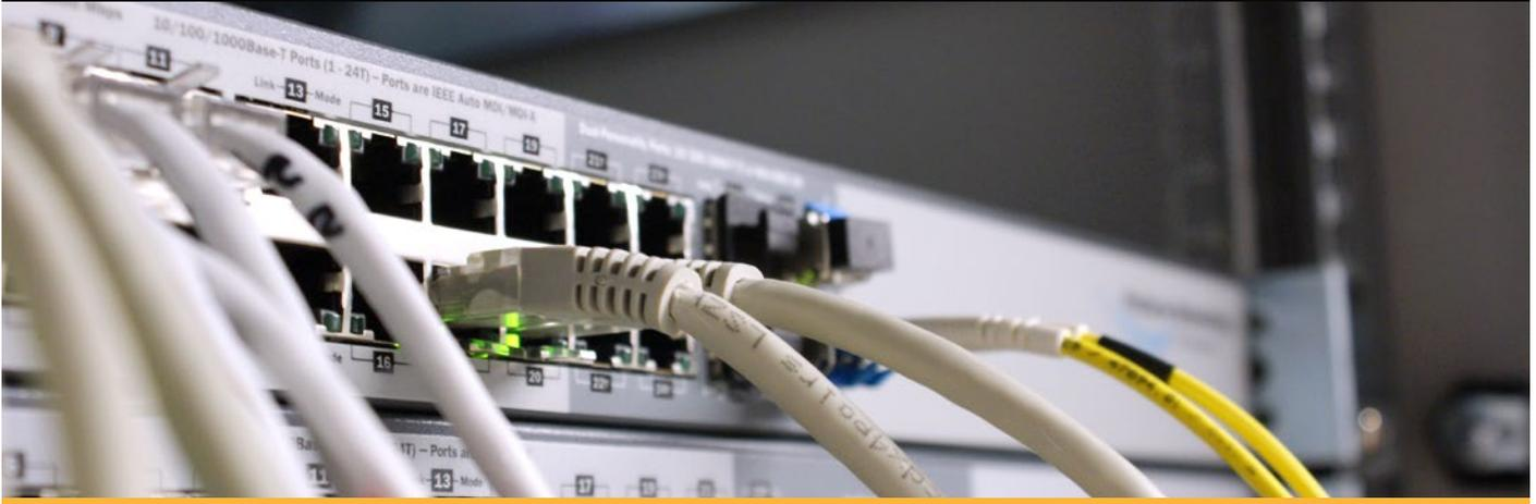
La sala de enlace de D-ALiX es el lugar idóneo para establecer interconexiones. La meet-me-room (MMR) de D-ALiX permitirá estas interconexiones mediante par trenzado, coaxial y fibra óptica, y de manera totalmente neutral.
