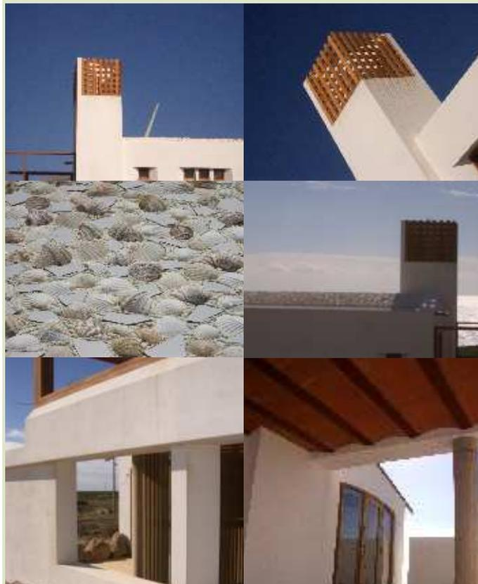
Esta comunicación entre cada espacio genera el flujo de aire en el interior, que se ve potenciado por la existencia de una torre de ventilación que cruza verticalmente la vivienda ayudando a eliminar el aire caliente del interior. Asimismo, toda la fachada norte cuenta con pequeñas aperturas a nivel del suelo que permiten la entrada de aire fresco de forma continuada a la vivienda.
