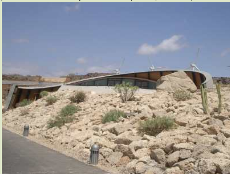
Vista de la vivienda
