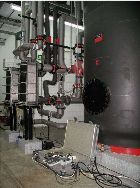
Toma de medidas en una instalación hotelera
