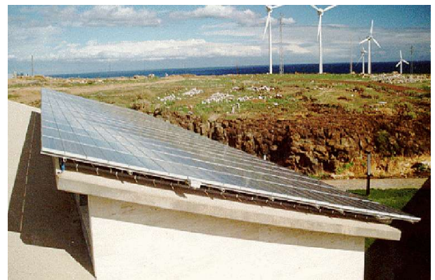
Instalación fotovoltaica en el tejado del edificio principal
