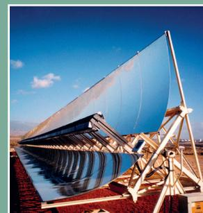
1996. Ponemos en marcha una Planta de Concentración fotovoltaica basada en el Prototipo EUCLIDES™ de 480 kW, la mayor del mundo conectada a red en esos momentos
