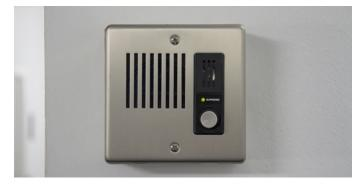
• Megafonía. El sistema de megafonía implementado permite al personal de la sala de control la comunicación con cualquier lugar del datacenter.
