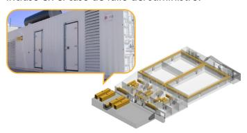
La infraestructura está comprendida por una doble acometida eléctrica, un sistema redundante de grupos electrógenos (2N), sistemas de alimentación ininterrumpida (2N+1) y centro de transformación (2N). Todo ello para proporcionar una autonomía de 48 horas a plena carga (depósitos 2N) con una infraestructura eléctrica que ha sido clasificada TIER IV.
