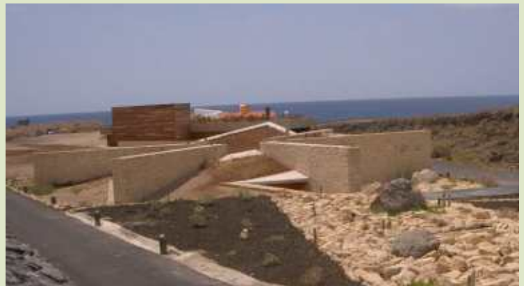
Vista de la vivienda
