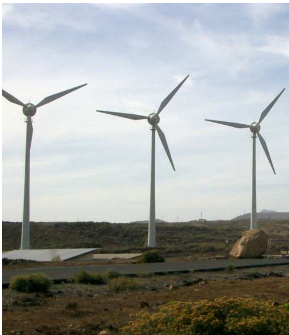
Parque Eólico de 5'5 MW
